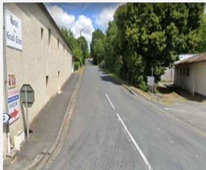
Maintien du dépôt rue « côte de Plaisance » (9 foyers de « Saint-Bris des Bois » concernés)
